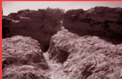
B Detalhe da vala de escoamento de águas
